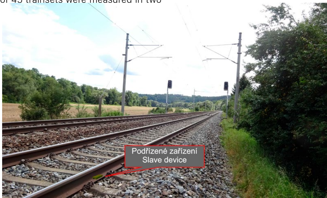
Obr. 6 Pohled na umístění snímací jednotku na kolejovém roštu
